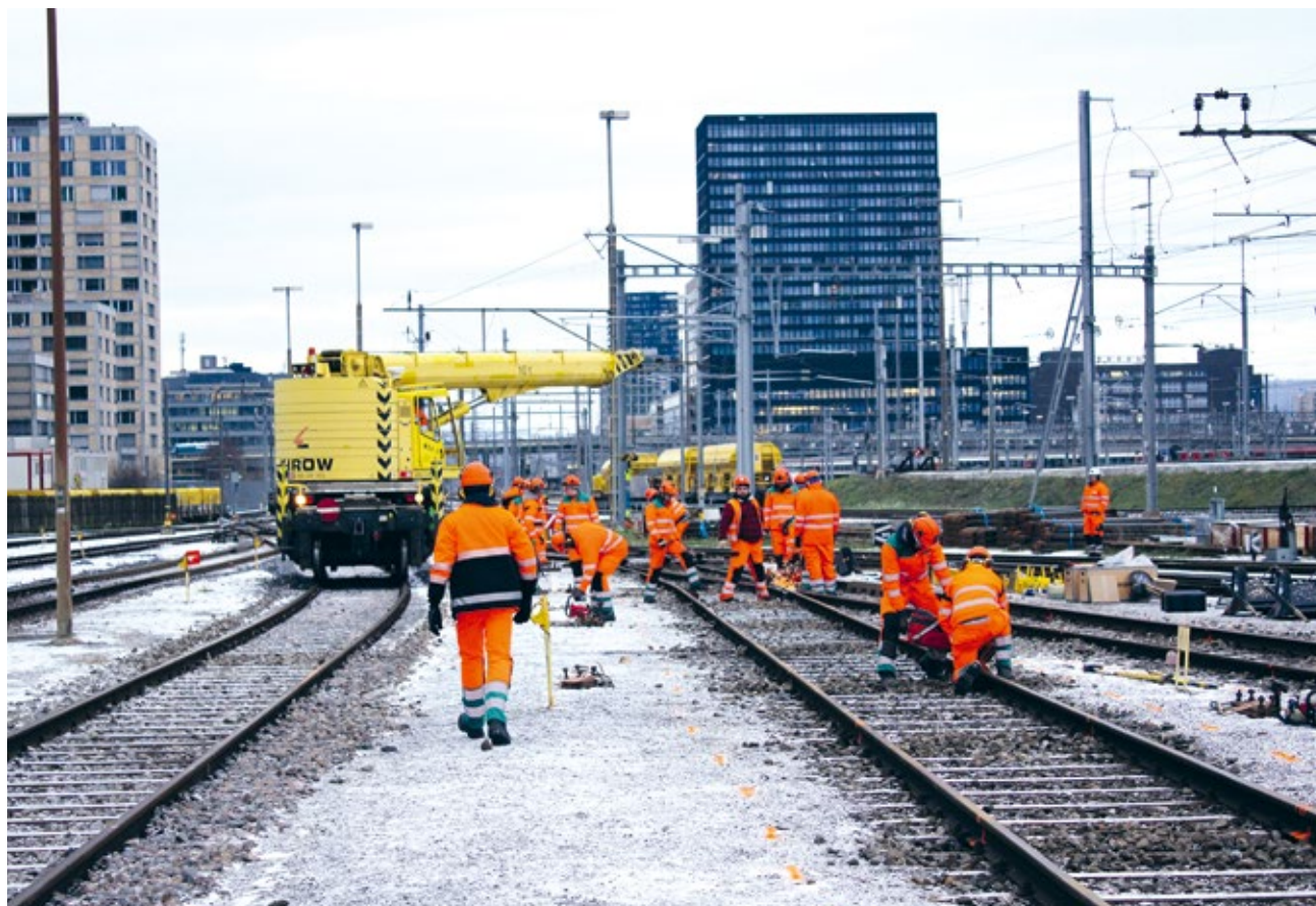
Auf jeder Gleisbaustelle wacht ein Sicherheitwärter (im Bild hinten rechts) über das Team.
